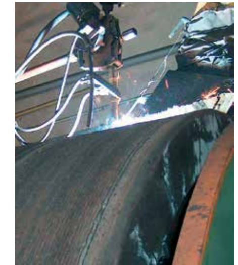
Kalenborner Service löst Verschleißprobleme vor Ort
