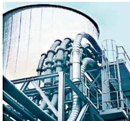
Bewährte Werkstoffe für Flugasche-Leitungen: ABRESIST, KALCOR oder KALOCER
