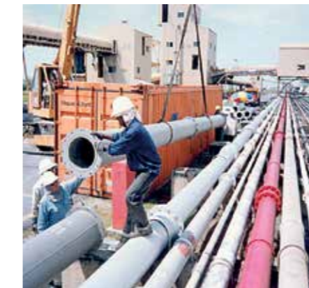
Montage einer Nassasche-Leitung (mit 350 mm Durchmesser) in Malaysia
