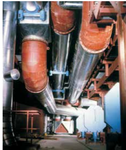
Typischer Einsatzfall in Kraftwerken sind Kohlestaub-Leitungen.
