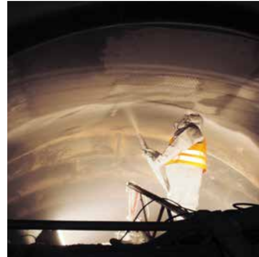
Schutz der Rohmehlleitungen gegen Reibverschleiß mit Hartstoffkompond KALCRET, Auskleidungsdicke 25 - 40 mm, Einsatztemperatur 200 °C
