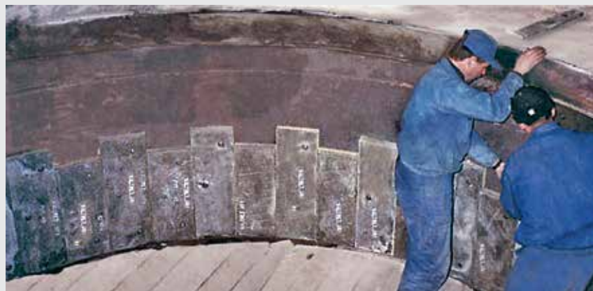
Schutz der Rohmehlleitungen gegen Reibverschleiß mit Hartstoffkompond KALCRET, Auskleidungsdicke 25 - 40 mm, Einsatztemperatur 200 °C
