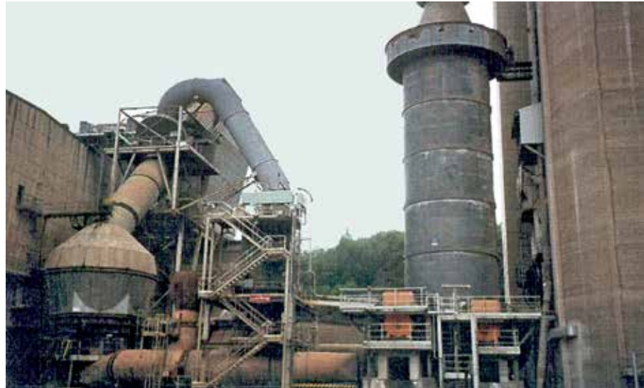
Sicherer Schutz der Rohmühle und des pneumatischen Rohrsystems mit Hartstoffkompond KALCRET BNX
