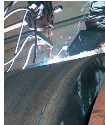
Kalenborner Service: Regeneration einer Mahlrolle mit KALMETALL W100
