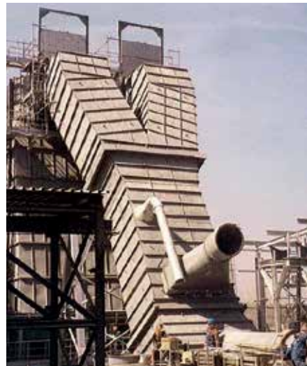
Auskleidung der Kühlerabgasleitung mit Hartstoffcompound KALCRET BNY
