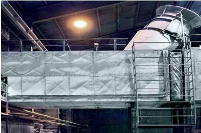
Schutz der Rohmehlleitungen gegen Reibverschleiß mit Hartstoffkompond KALCRET, Auskleidungsdicke 25 - 40 mm, Einsatztemperatur 200 °C
