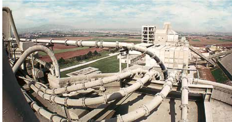
Rohrleitungen in der Zementindustrie werden sicher geschützt mit ABRESIST, KALCRET oder bei extremem Verschleiß mit KALCOR und KALOCER
