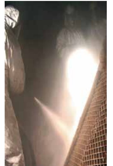
Kurze Auskleidungszeiten eines Wirblers erzielt man in der kombinierten Auskleidung von Hartstoffkompond KALCRET BTS und Zirkonkorund KALCOR. Die Aufbringleistung von KALCRET BTS reicht bis zu 5 m²/h
