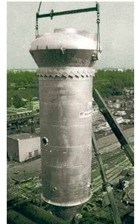
Entstaubungszyklone für Hochofen werden wirkungsvoll durch optimale Werkstoffkombination geschützt
