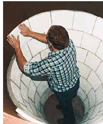
Passgenau gegossene Zirkonkorund KALCOR Formstücke gewährleisten im Konus eines Staubabscheiders sichereren Verschleißschutz auch bei hohen Temperaturen und starken Temperaturwechseln
