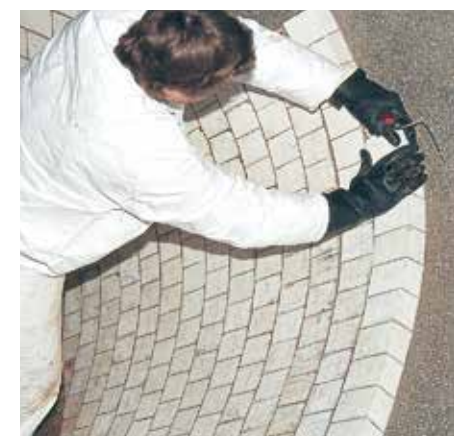
Kalenborner Service löst Verschleißprobleme vor Ort
