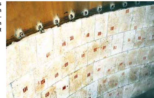
Kurze Auskleidungszeiten eines Wirblers erzielt man in der kombinierten Auskleidung von Hartstoffkompond KALCRET BTS und Zirkonkorund KALCOR. Die Aufbringleistung von KALCRET BTS reicht bis zu 5 m²/h
