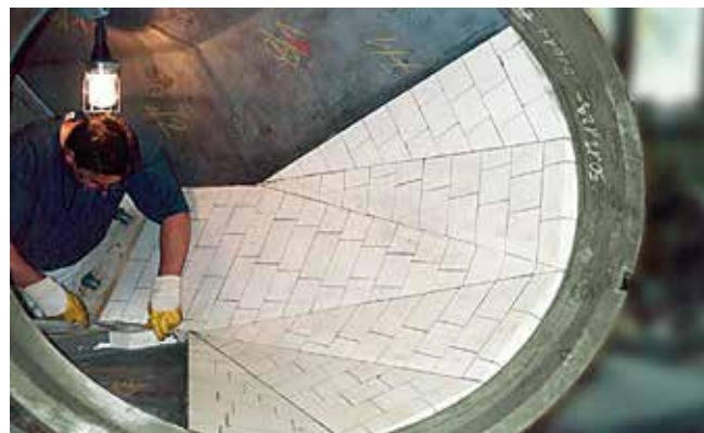
Achtecktrichter mit KALOCER Auskleidung; die 50 mm dicken Formstücke sind zur optimalen Anpassung dreidimensional geschnitten
