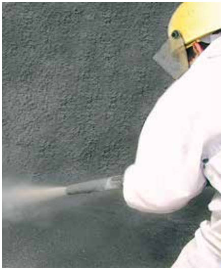
Kalenborner Service löst Verschleißprobleme vor Ort
