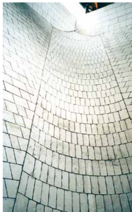
Bunker für die Hochofen-Beschickung werden wirkungsvoll mit KALOCER gepanzert
