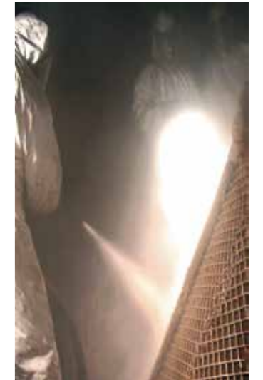
Kurze Auskleidungszeiten eines Wirblers erzielt man in der kombinierten Auskleidung von Hartstoffkompond KALCRET BTS und Zirkonkorund KALCOR. Die Aufbringleistung von KALCRET BTS reicht bis zu 5 m 2 /h
