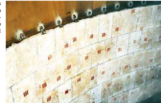
Kurze Auskleidungszeiten eines Wirblers erzielt man in der kombinierten Auskleidung von Hartstoffkompond KALCRET BTS und Zirkonkorund KALCOR. Die Aufbringleistung von KALCRET BTS reicht bis zu 5 m 2 /h
