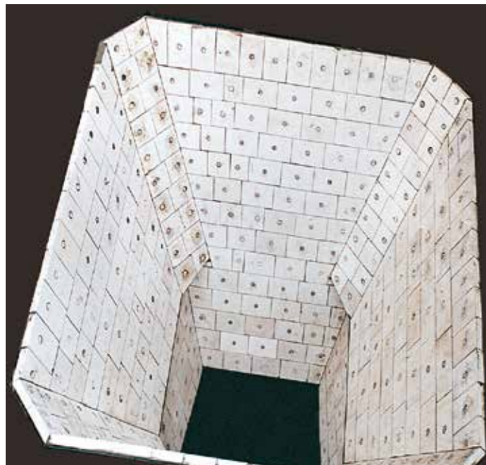
Trichter in der Befüllung mit mechanisch befestigten KALOCER Platten
