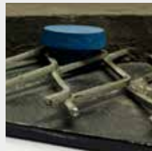
Rautengitter mit Indikatorsteinen KALDETECT für die Verschleißschutzüberwachung
